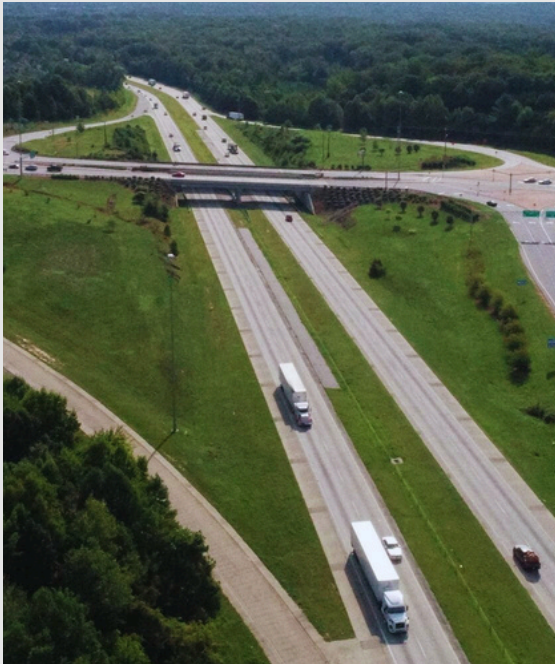
Vista aérea del progreso de la construcción de la autopista Northern Beltway.
