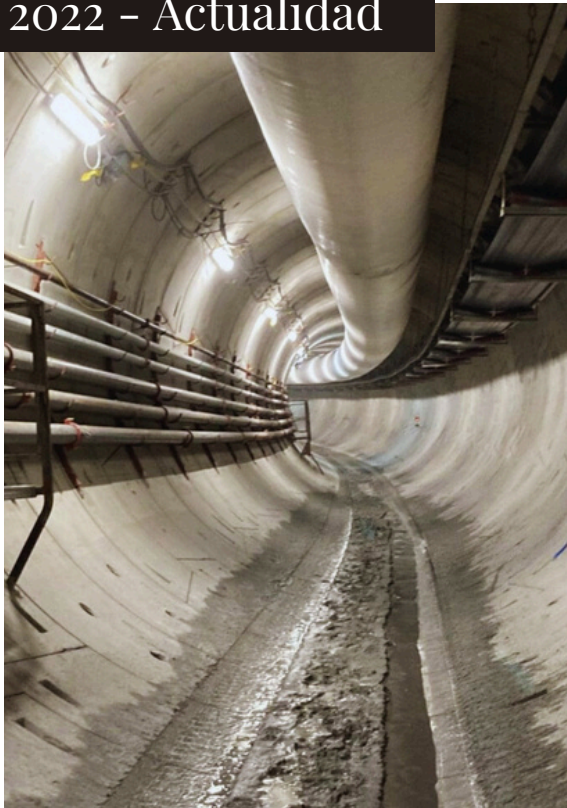
Vista general del proyecto en construcción.
