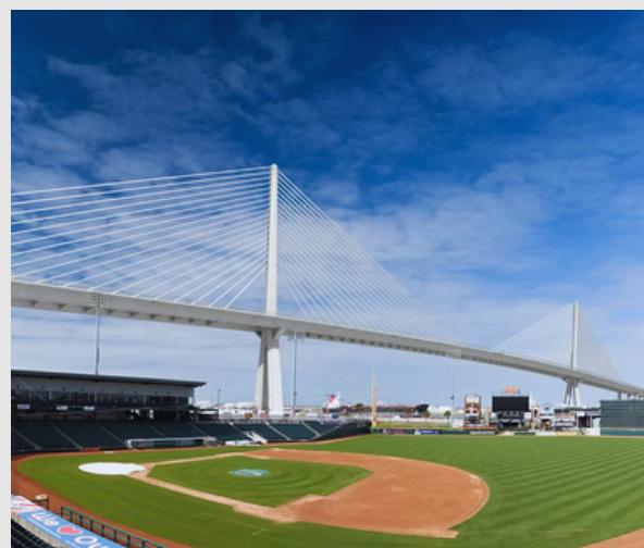
Proyecto de reemplazo del US 181 Harbor Bridge.
